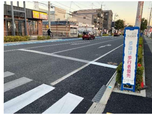
図 2-12 カラーデザイン蓋設置状況（消火栓・耐スリップ型）
