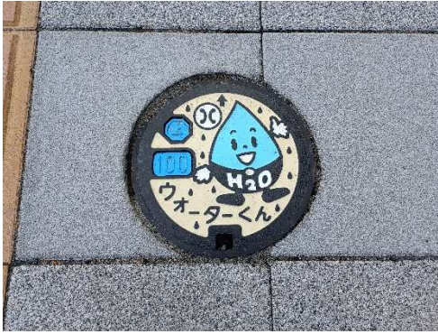
図 2-10 カラーデザイン蓋設置状況（仕切弁・複数カラー）
