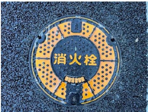
図 2-12 カラーデザイン蓋設置状況（消火栓・耐スリップ型）
