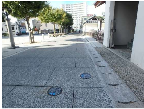
図 2-11 カラーデザイン蓋設置状況（仕切弁・単数カラー）
