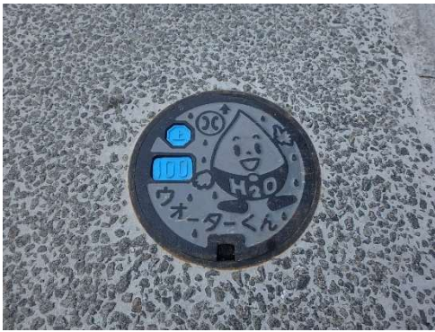
図 2-11 カラーデザイン蓋設置状況（仕切弁・単数カラー）
