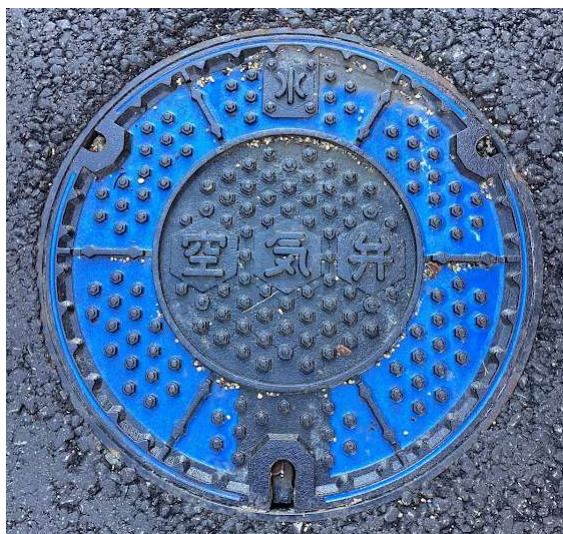
図 2 - 2 1 空気弁における車道用耐スリップ型鉄蓋 (例)
