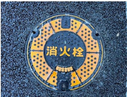
図 2-12 カラーデザイン蓋設置状況（消火栓・耐スリップ型）
