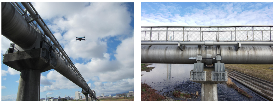
図 3-5 ドローンを活用した水管橋の点検
