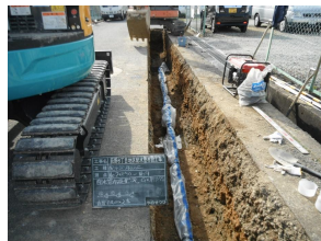
図 5-7 配水管更新工事の状況
