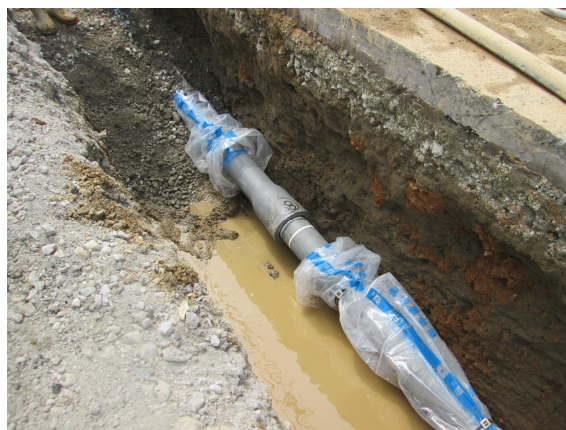
図 3-2 耐震管布設状況
