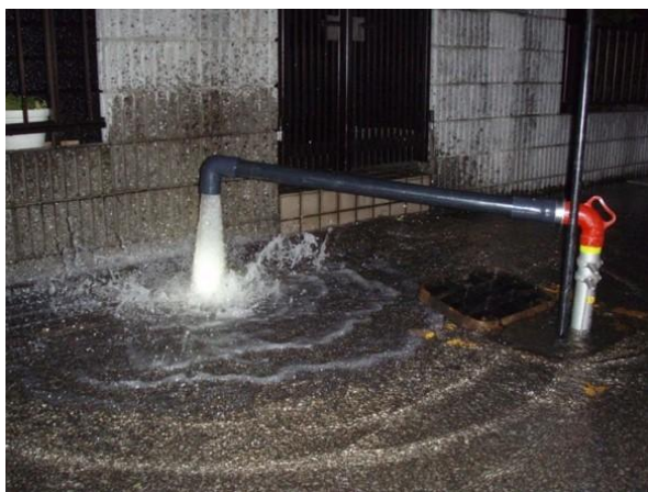
図 5-3 配水管の洗管（左図）と配水池内面（右図）
