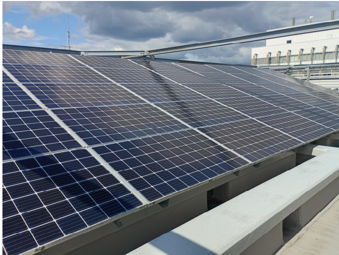
図 5-16 太陽光発電設備の導入（上下水道局庁舎屋上）
