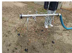
仮設給水蛇口
