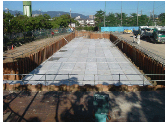
◇工事中の状況
