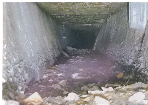
◇水路内部の状況②
