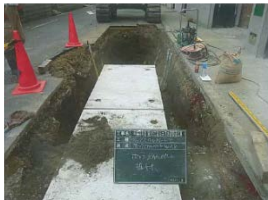
◇ボックスカルバート敷設状況
