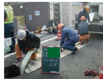
◇管渠更生の作業状況
