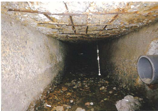
◇水路内部の状況①
