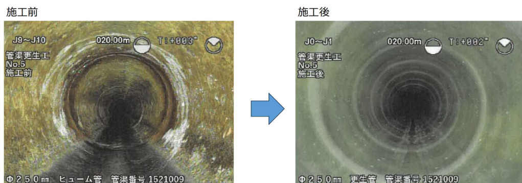
図 5-4 管渠更生工事の状況
