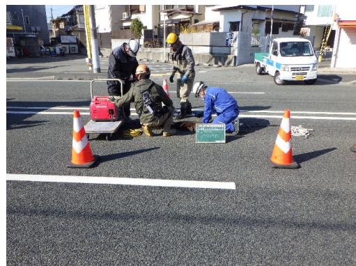
図 4-3 大規模下水道管渠の点検状況
