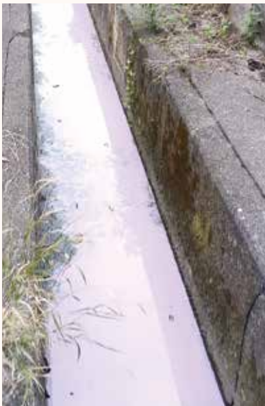
▲ペンキが流された水路
