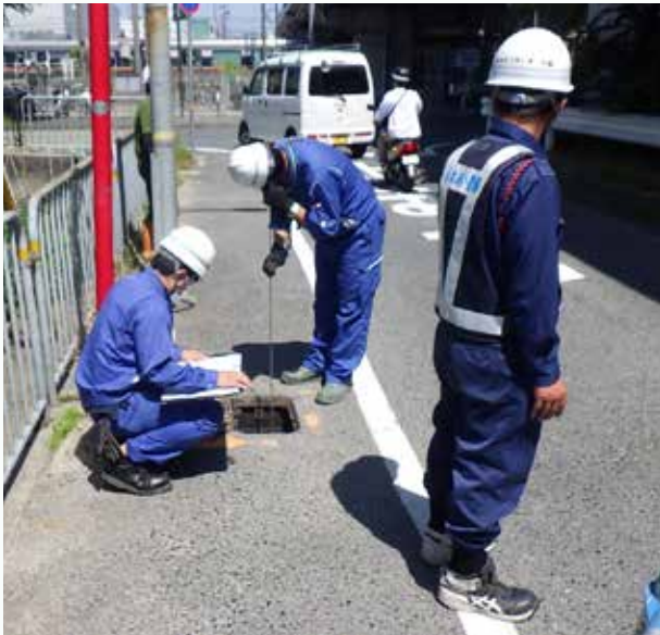
▲緊急点検（消火栓内の漏水確認）の様子
