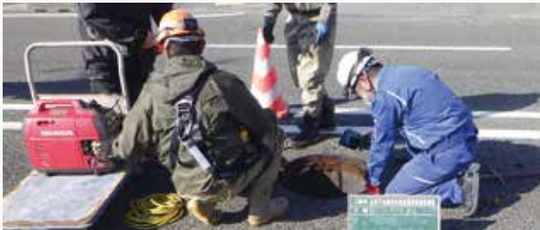
▲緊急点検（マンホール目視点検）の様子
