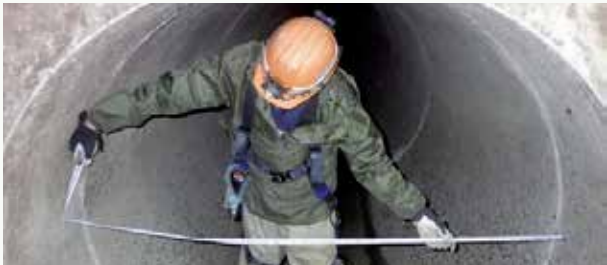
▲緊急点検（污水管内目視点検）の様子
