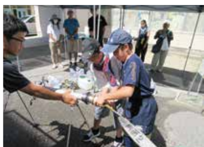
▲受水槽からホースを仮設給水蛇口へ取付
