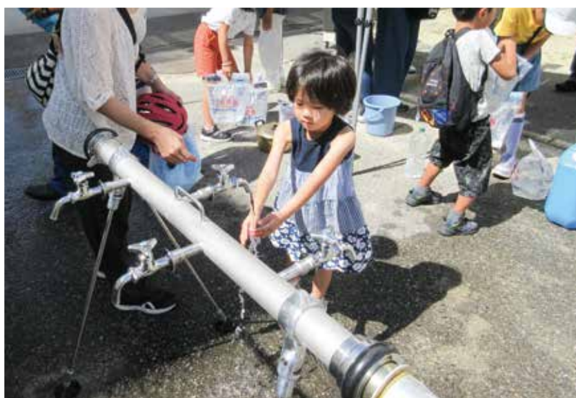
▲仮設給水蛇口より放水
