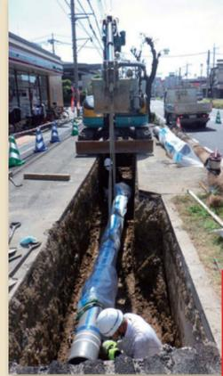
地面を直接掘って新しい水道管に更新している様子(開削工法)
